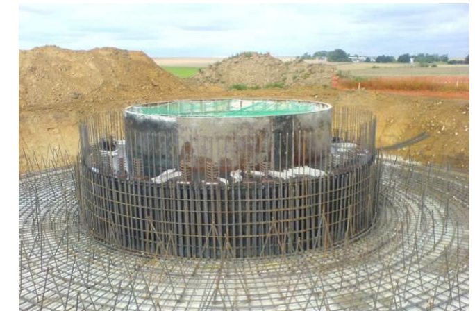
Création de fondation
