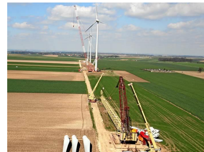
Montage d'une éolienne
